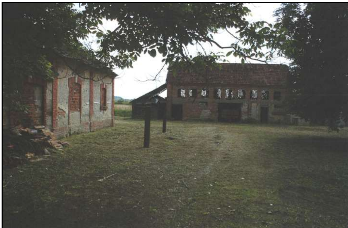
Slika 5 Postojeće stanje Tenovog mlina
