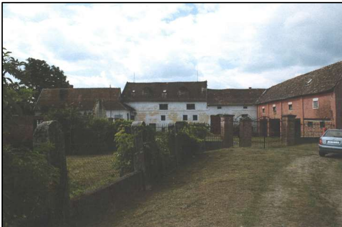
Slika 3 Postojeće stanje Tenovog mlina
